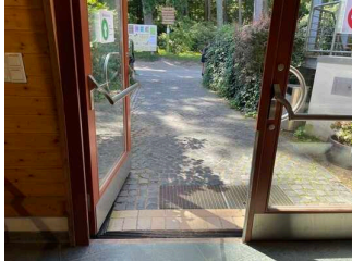
Tür 2 von Eingangshalle in das Außengelände
